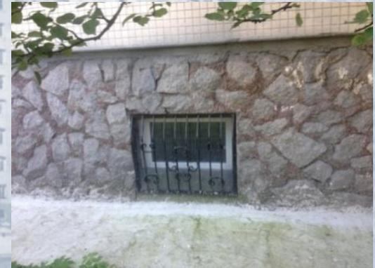
01.06.2014-01.07.2015 установка энергосберегающих окон с защитной решеткой в подвале и утепление дверных блоков на входе в подъезды, замена на энергосберегающие дверных блоков на переходных балконах и обеспечение автоматического закрывания дверей.
